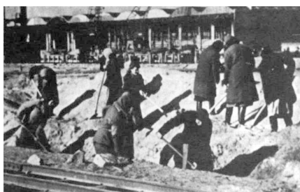
Zwangsarbeiterinnen beim Bau des Diestel-Kais
